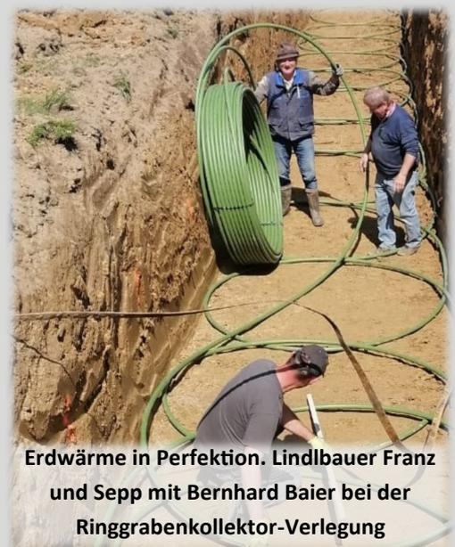
Erdwärme in Perfektion. Lindlbauer Franz und Sepp mit Bernhard Baier bei der Ringgrabenkollektor-Verlegung
